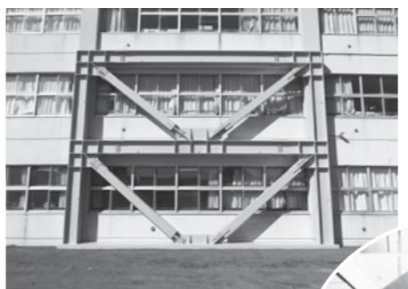
進められる耐震改修促進計画
